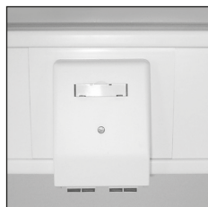
Montage im Brüstungskanal Installation in dado trunking
